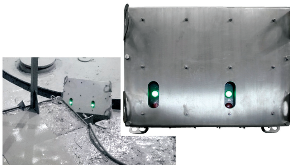
Рис.3. Стойки регистрации САС СЦР, установленные на объекте.
