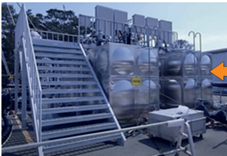
Рис.11. Система впрыска соединения бора на F-1 (баки системы указаны стрелкой).
